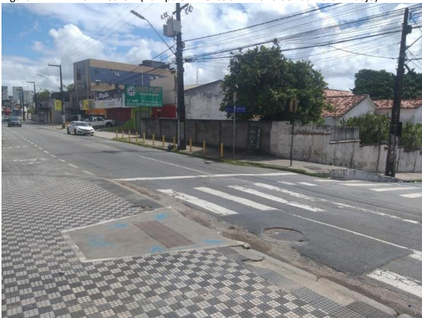
Figura 127: Av. Dom Pedro II (Rampa em frente a R. Maria de Fátima U. Araújo)
