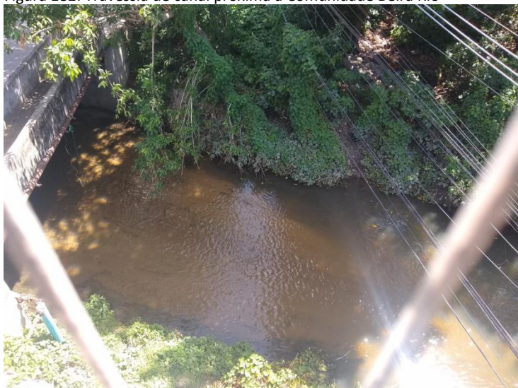
Figura 182: Travessia de canal próxima à Comunidade Beira Rio
