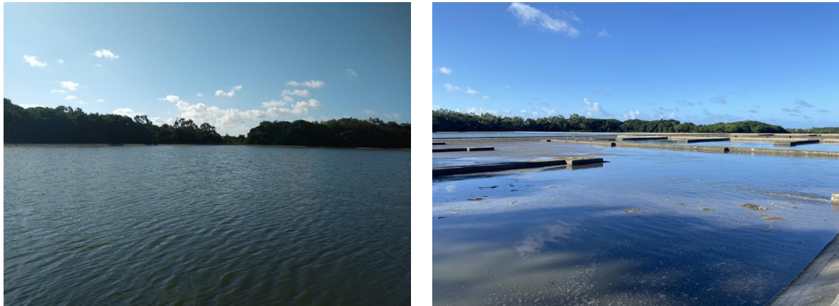
Figura 180 - Estação de Tratamento de Efluentes - Mangabeira
