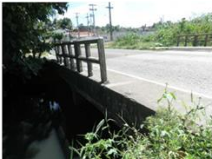
Figura 183: Estrutura Bicelular no rio Jaguaribe sob a Rua São Geraldo
