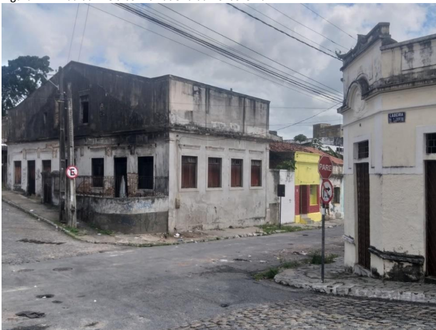
Figura 117: Rua da Areia com a Ladeira da Borborema
