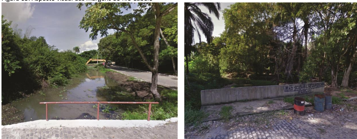
Figura 63: Aspecto visual das margens do Rio Cabelo
