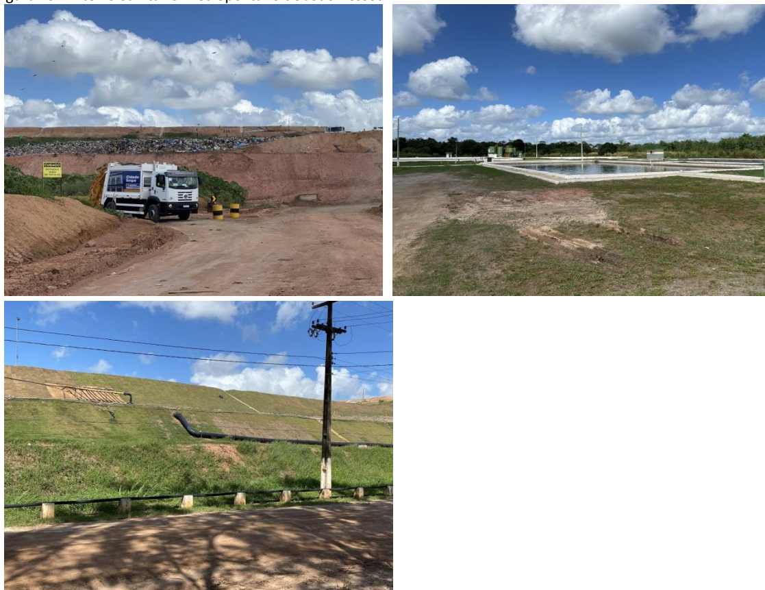
Figura 194: Aterro Sanitário Metropolitano de João Pessoa.
