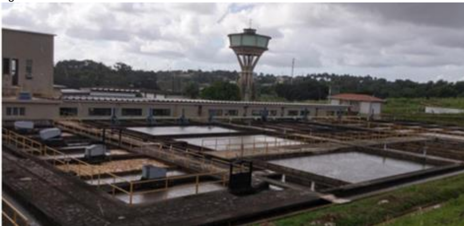
Figura 178: ETA de Marés
